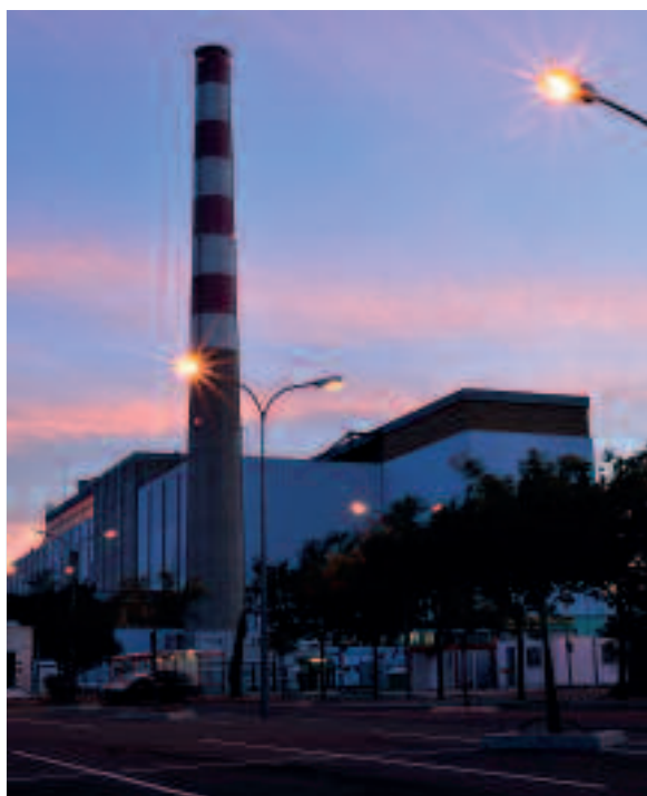
The CEA PHÉNIX reactor in Marcoule (Gard département)
